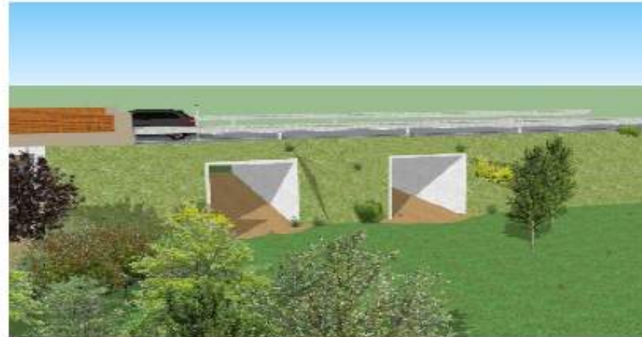
Figure 41 : Exemple de passage à faune sous-infrastructure routière (sans entonnement ici)
